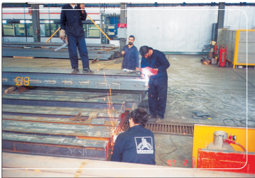
عملیات اجرایی ساخت خوابگاه آغاز شده است
